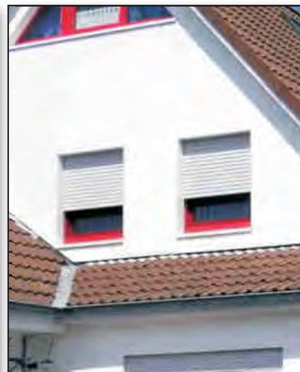
Aufsatzkästen in der Fassade
