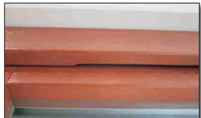
Rahmenfräsung (Zuluftöffnung) auf Außenseite
