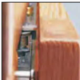
Sicherheitsschließstücke und Pilzzapfen
