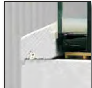
Glasleistenrahmen / Abdichtung mit Dichtprofil
