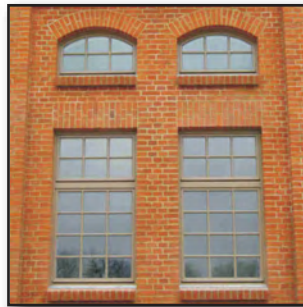
Sprossen (glasteilend, Wiener & im Scheibenzwischenraum)
