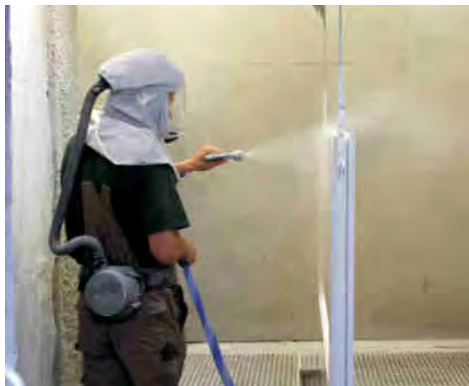
Schlussbeschichtung im Spritzverfahren
